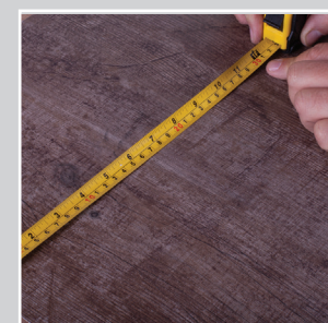
2 - Meça e corte as peças antes de retirar o plástico
