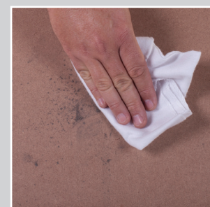
1 - Limpe a área a ser revestida
